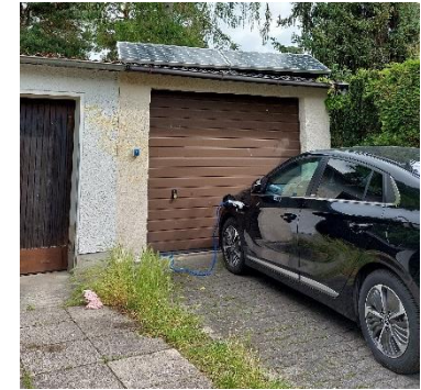
PV auf Garage und E-Ladestation
