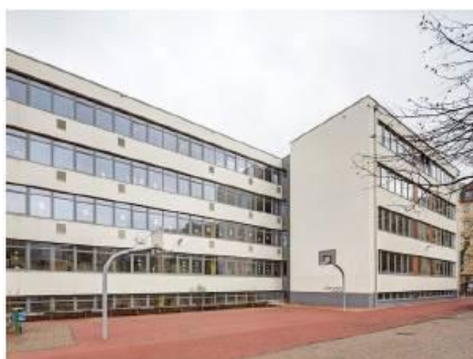
Die hofseitige Fassade nach der Sanierung
